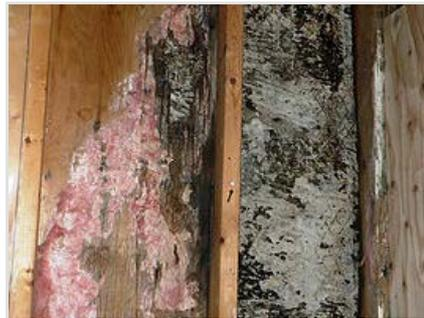
壁内に水分が浸入して劣化した直張り構法の耐力壁。構造用合板、防水紙が劣化により剥がれ落ち、錆びた平ラスやモルタルが露出している。
